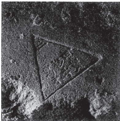
写4 杉本煉瓦製造所刻印（草津線新道暗渠）
