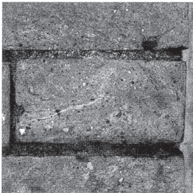
写1 旧長浜駅舎使用煉瓦
