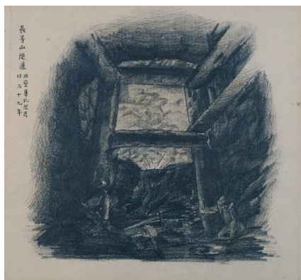
「長等山隧道 掘鑿導坑爆発」
