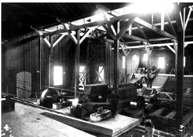
4-4 「第一期蹴上発電所 内部(1)」明治24年12月 (京都市上下水道局・田邊家資料)
