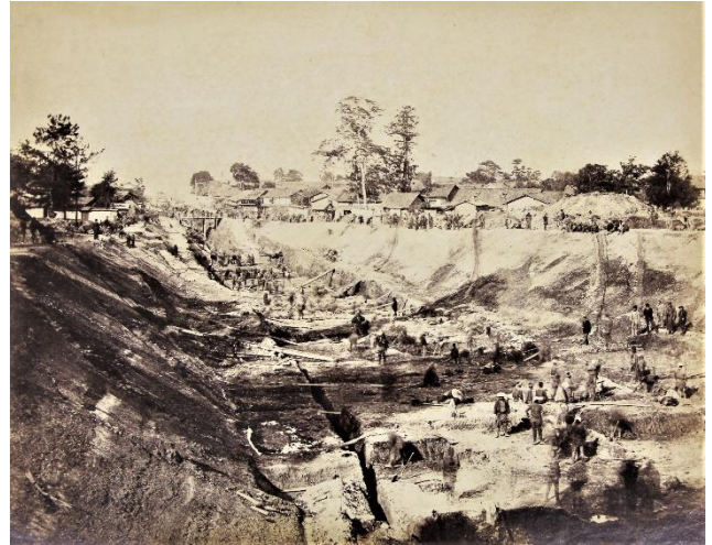
2-1 「琵琶湖疏水東口掘割工場」明治19年【資576】
